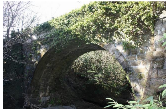
写真 2 : 巴橋のアーチ
