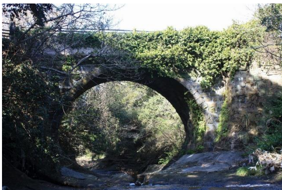
写真 1 : 上流から見た巴橋全景
