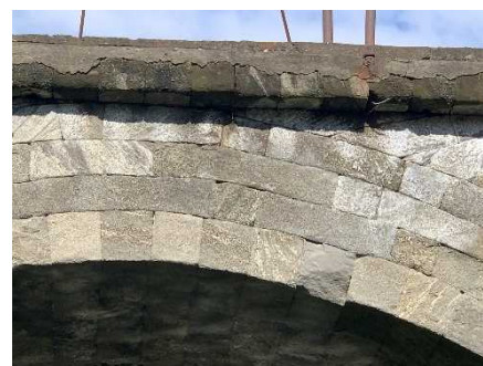
写真2: アーチリングの石積み
