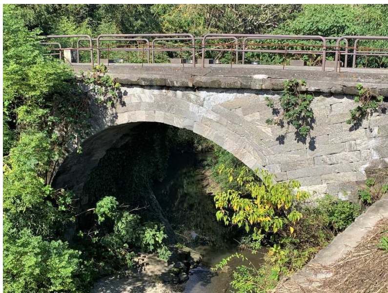
写真1: 汐止橋全景(下流側より)
